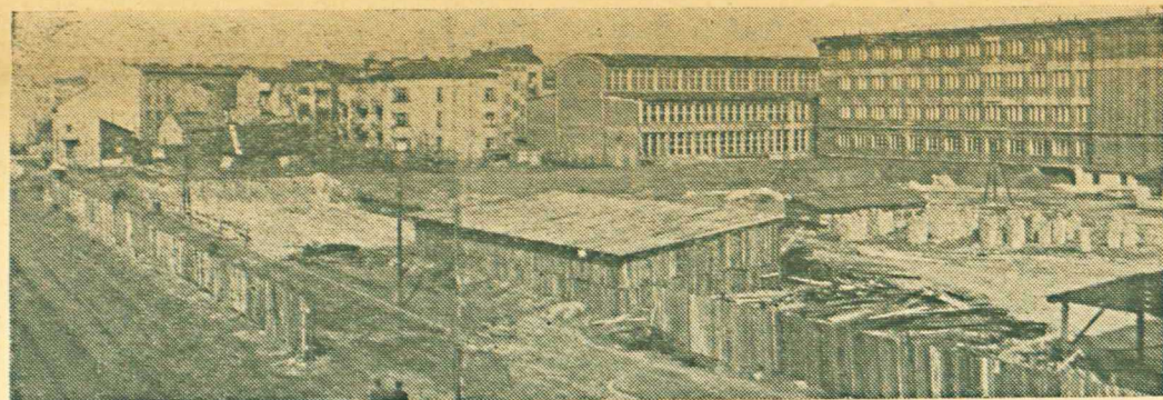
Nasz fotoreporter E. Król, który zawsze w obiek- tywie zainteresowań trzyma najbardziej czule miejsca życia Uczelni sfotografował swoim pa- noramicznym aparatem prace ziemne przy budo- wie nowego „Pawilonu Czarnej Metalurgii” (B4)
